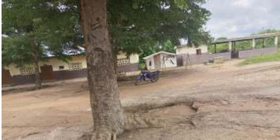
Photo 1 : L'un des deux bâtiments et la cantine de l'EPP SOLIBRA
