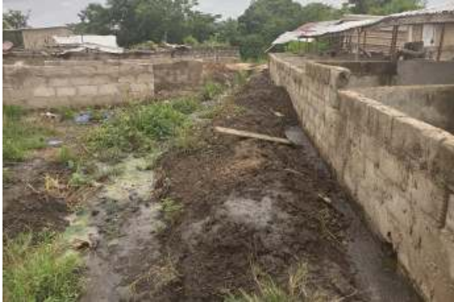
Photo 7 : Un ensemble de porcheries installées entre la SOLIBRA et le fleuve Marahoué
